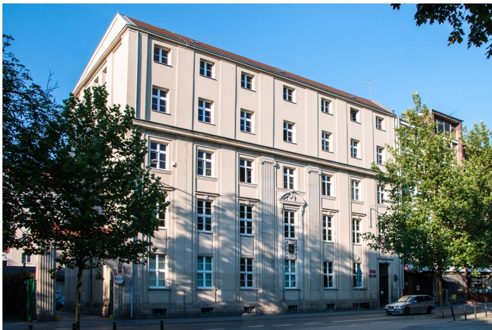
Budynek Okręgowego Urzędu Miar w Poznaniu
